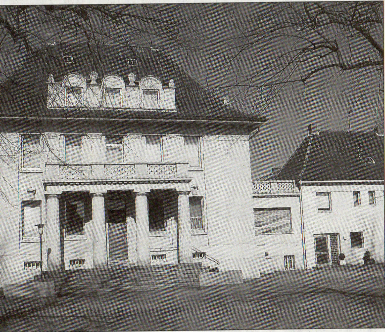
Das Annastift war das erste Geburtshaus in Beckum. Zuletzt beherbergte das Hauptgebäude die Firma Cemdata, die vor gut zwei Jahren aufgelöst wurde. In einem weiteren Gebäudeteil residiert die Betonmarketing West GmbH. Die Firmen Normensand GmbH als Eigentümerin des 2000 Quadratmeter großen Areals sucht nach einer passenden Folgenutzung. Bild: Schürbüscher
